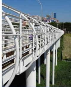
INSTALAÇÃO DO GRADIL EXTERNO NO VIADUTO DO LADO PARAGUAÍO – FACE NORTE
